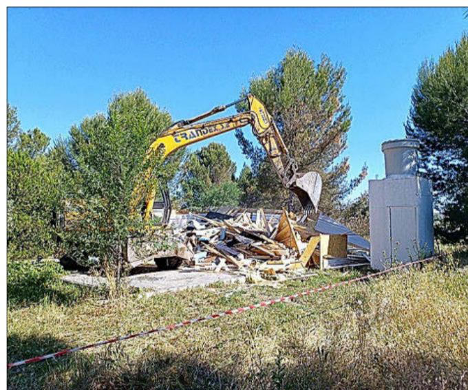
Una excavadora tirando abajo una construcción ilegal. E. M.
